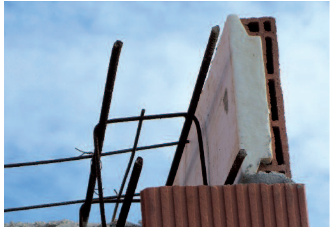
Aplacat de forjat
