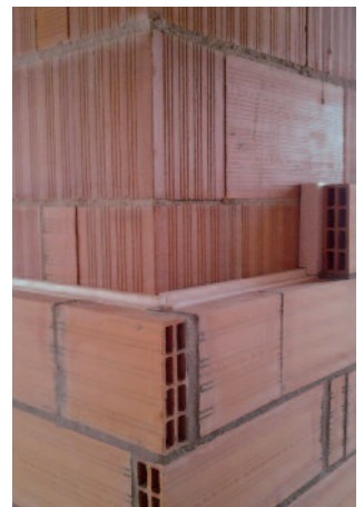
Continuïtat de l'aïllament per la part interior dels angles
