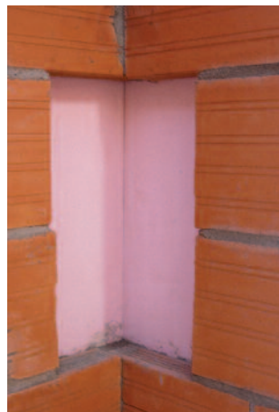
Continuïtat de l'aïllament per la part interior dels angles
